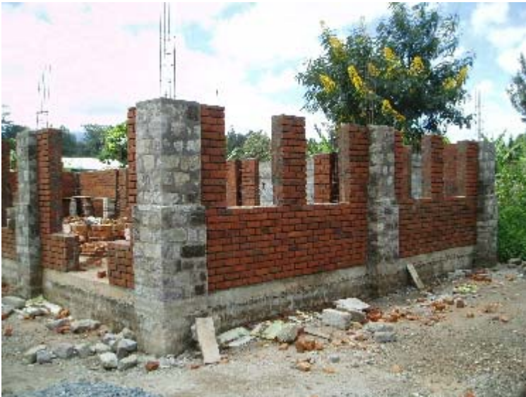
Väggarna är uppe på bygget nere i Ngaramtoni by
